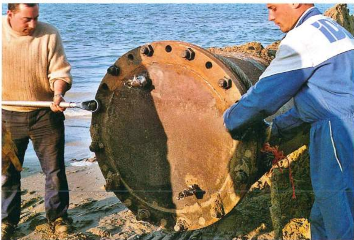
Figura 9 - In alto: tubazione pronta per il varo sulla spiaggia di Cervia; in basso: piastra di chiusura degli estremi della tubazione per renderla galleggiante.
