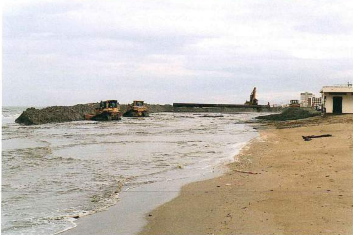
Figura 12 - Modalità di distribuzione della sabbia. In alto: la spiaggia di Riccione ricostruita dal libero fluire verso mare della miscela acqua sabbia. In basso: la spiaggia di Milano Marittima ricostruita contenendo il flusso acqua sabbia con un argine lato mare.
