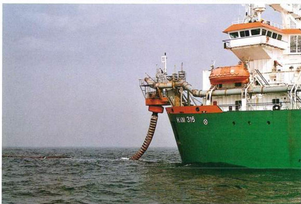
Figura 11 - Spiaggia di Cervia: operazioni di collegamento tra il segmento galleggiante e la tubazione in acciaio; in basso: in evidenza la congiunzione tra la tubazione della nave e il tratto galleggiante collegato alla tubazione di mandata a terra.
