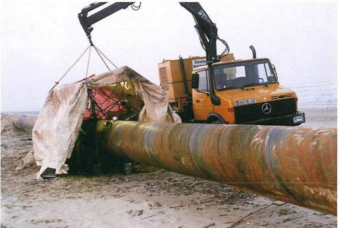
Figura 8 - Spiaggia di Cervia: in alto, distribuzione lungo due linee dei singoli tubi; in basso, struttura mobile adibita alla saldatura dei singoli elementi.
