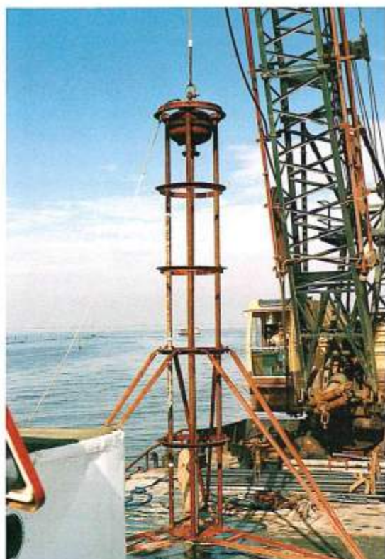
Figura 4 - Il carotiere utilizzato per la campagna geognostica 2000 in posizione verticale sul pontone.
