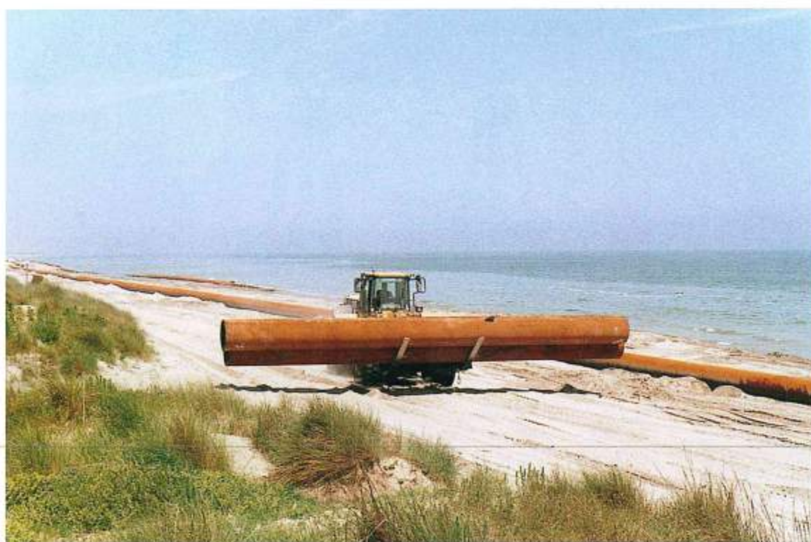
Figura 13 - Operazioni di recupero e risonatura delle tubazioni a fine lavori.
