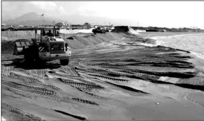
Figura 5 - Stendimento del materiale di ripascimento.
