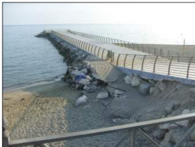
Figura 11 - Molo presso la strada lungomare di Capitello (SA) nel 2011. La struttura, similmente a quanto è avvenuto per il porto di Capitello, ha intercettato la corrente lungocosta Est – Ovest creando una zona di sedimentazione nel lato sopraflutto (a destra nella foto) e di erosione nel lato sottoflutto (a sinistra nella foto). Per questo motivo anche il radicamento del molo dal medesimo lato è stato rinforzato con blocchi calcarei.
