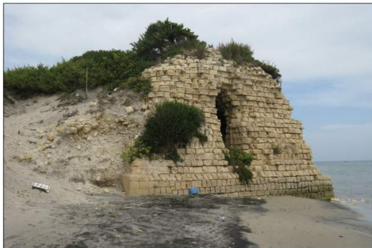
Figura 10 – L'azione delle onde di mareggiata ha posto in evidenza la struttura dei depositi che si appoggiano sui lati verso terra di Torre Fiumicelli. E' ben visibile il corpo di frana, probabilmente prodotto dal terremoto del 20 febbraio 1743. In primo piano sul bordo interno della spiaggia emersa è visibile una concentrazione meccanica di minerali vulcanici di colore scuro provenienti dall'erosione dell'edificio vulcanico del Monte Vulture.
