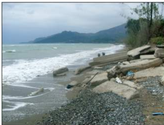
Figura 9 - Particolare della spiaggia di Marina di Capitello, drasticamente ridotta nel 2011 a seguito delle mareggiate. I resti della strada costiera giacciono pericolosamente in balia delle onde frangenti.
