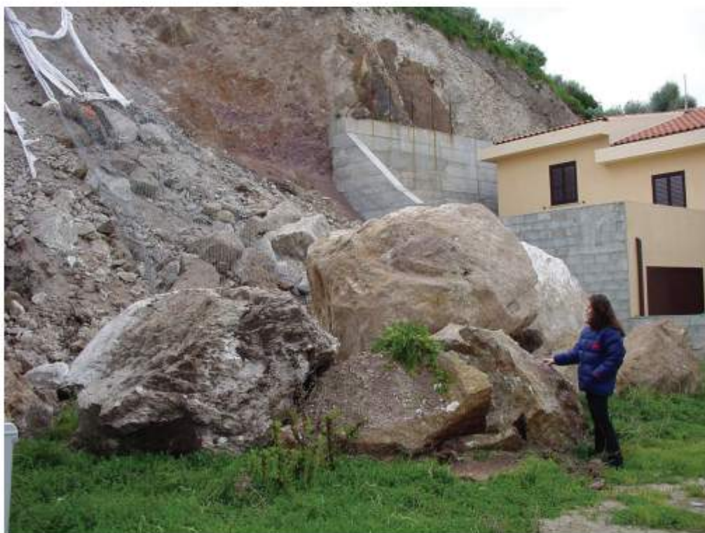
Figura 12 – Gli eventi estremi dei primi anni 2000 hanno determinato diffusi dissesti nell'area urbana di Castelsardo, coinvolgendo anche i depositi carbonatici del Miocene a monte della Via Zirulia, indicati con M2c nella Fig. 4.
