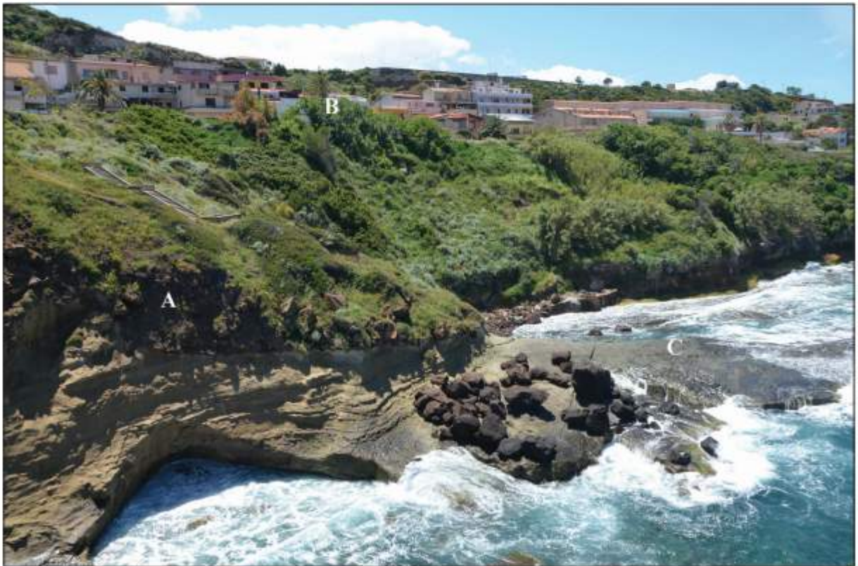
Figura 8 – La falesia di Via Zirulia di Castelsardo mostra l'espansione urbana nel terrazzo (B) sulle eolianiti pleistoceniche (A), alla base della stessa si osservano i blocchi riesumati della paleofalesia che poggiano sulla piattaforma attuale (C).
