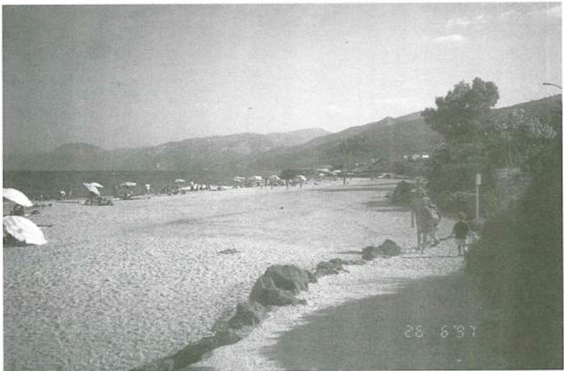
Figura 12 - La Spiaggia Centrale dopo la conclusione dei lavori (Estate 1997)
