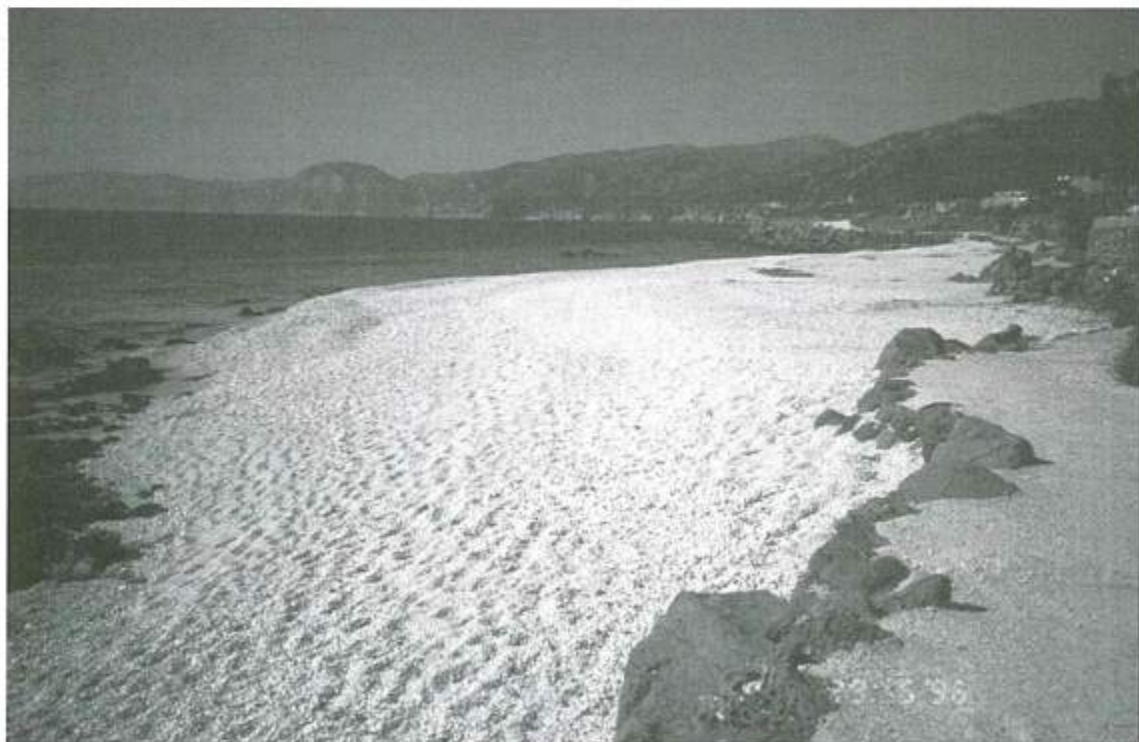
Figura 9 - La Spiaggia Centrale 1 anno dopo la fine dei lavori della prima fase (Maggio 1996)
