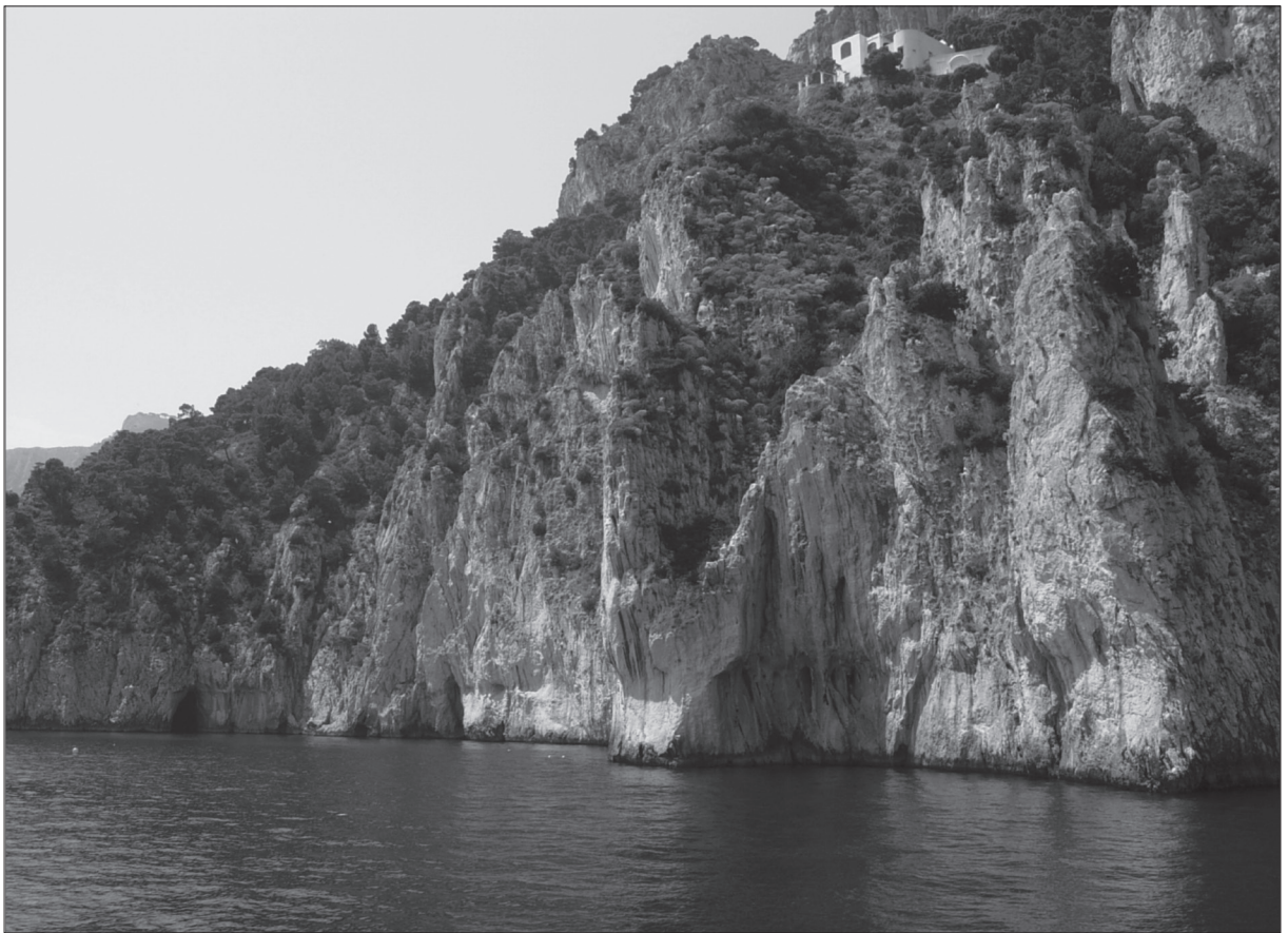
Figura 4 - La ripida falesia a sud dell'Isola di Capri, caratterizzata da faglie, solco di battente e cavità (2013).
