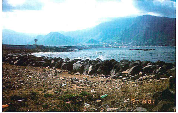
Figura 15 - Scogliera aderente a difesa dello scarico del Canale industriale nel tratto settentrionale del litorale.
