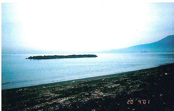
Figura 21 - La scogliera parallela posta nel settore n. 2. A causa di uno sfavorevole rapporto lunghezza/distanza da riva, la sua efficacia è assai limitata e determina solo un debole saliente.
