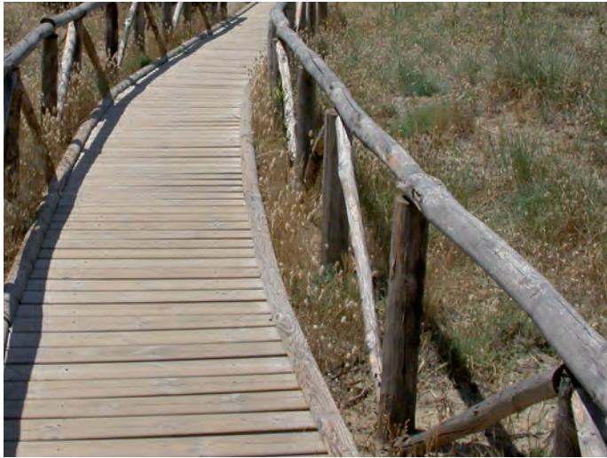
Figura 10 - Modello di passerelle in legno, con o senza staccionate, previsto per l'area di Sterpaia (tipologie utilizzata nell'ambito del Parco Regionale di Migliarino, San Rossore e Massaciuccoli).
