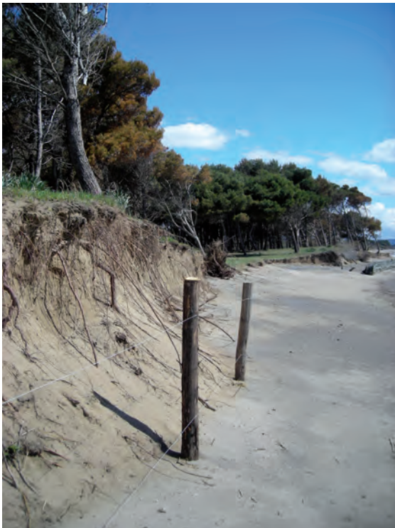
Figura 3 - Erosione sistema dunale con diffuso scalzamento al piede, crollo del fronte dunale e messa a nudo degli apparati radicali (Loc. Carlappiano).
